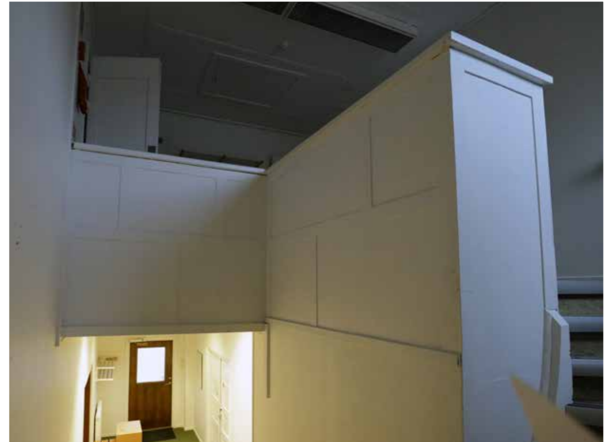
Trapphuset. Notera listverket som skapar den dekorativa panel på väggen.
