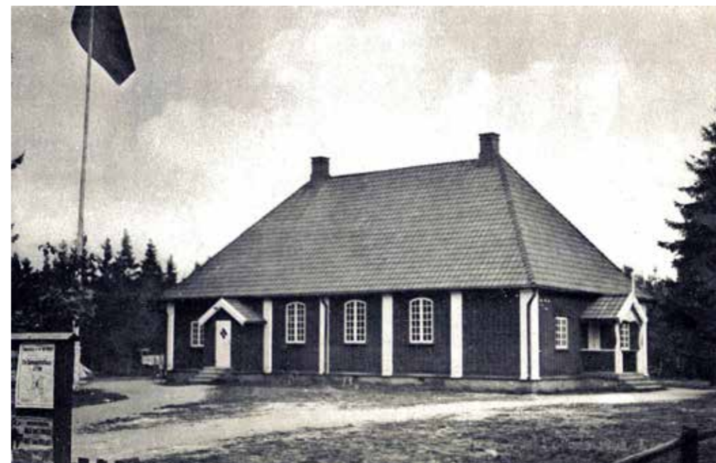
Den första Folkets hus byggnaden som uppfördes i Lessebo 1917. Byggnaden uppfördes tidstypisk nationalromantisk stil, vilken bland annat karaktäriseras av de småspröjsade fönstren och det höga valmande sadeltaket. Fotograf okänd. Bild tillhandahållen av Lessebos hembygdsförening.
