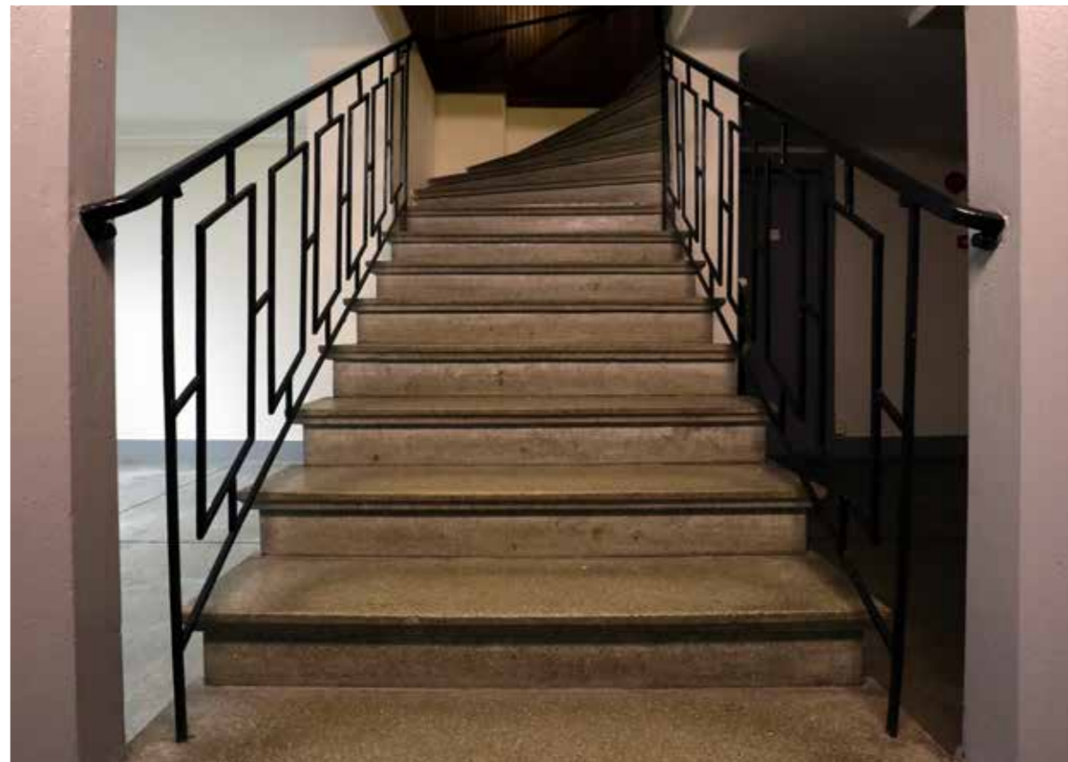
Formgjuten trappa i terrazzo. Notera den dekorativa trappnosen och de smidda räckena.
