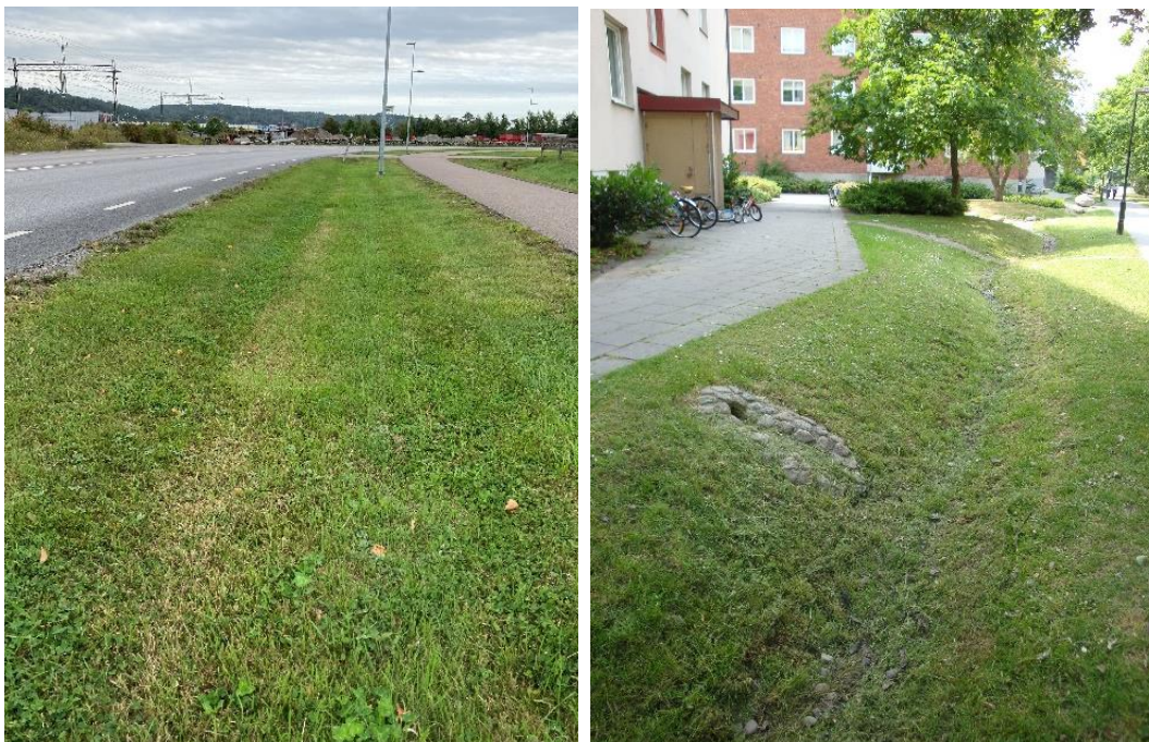
Exempelbilder makadamdike/infiltrationsstråk. Foto: Sweco
