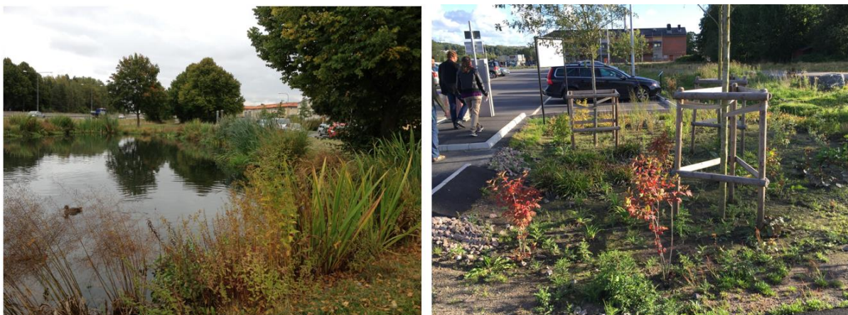
Figur 5: Exempelbilder på hållbara dagvattenanläggningar. Foto: Sweco
