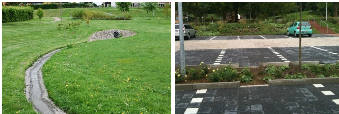
Figur 6: Exempelbilder på öppna dagvattenanläggningar. Foto: Sweco
