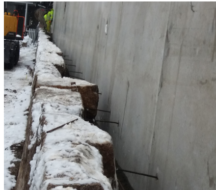
Den gamla stödmuren förankras i den nya betongmuren för maximalt stöd och säkerhet
